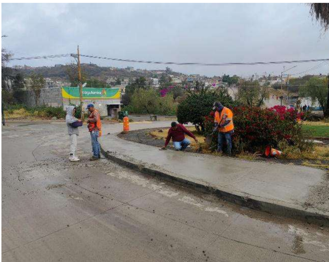
IMAGEN 15. Ampliación de glorieta para reducción de carriles. Crédito DGOP.
