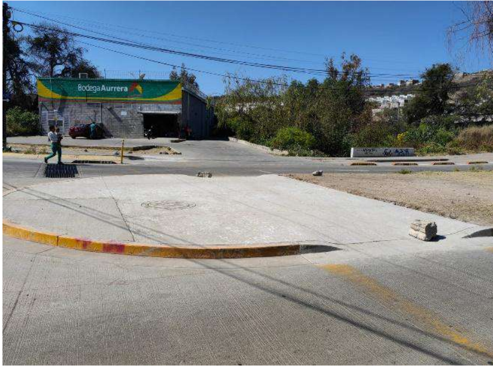
IMAGEN 16. Mejora de paso peatonal en camellón. Crédito DGOP.
