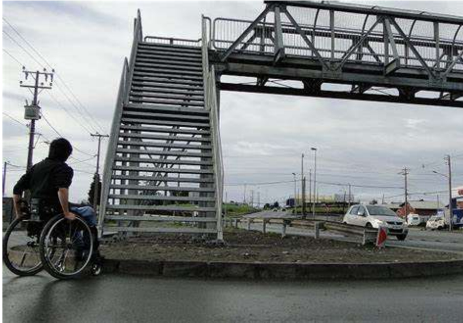
IMAGEN 31. Ejemplo 3.1 Abordaje convencional Puente peatonal que prioriza el tránsito vehicular. Crédito: https://www.ciudadaccesible.cl/
