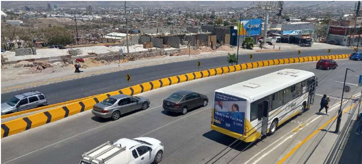
IMAGEN 26. Barrera de contención de concreto terminada el 14 de marzo de 2024. Crédito DGM.
