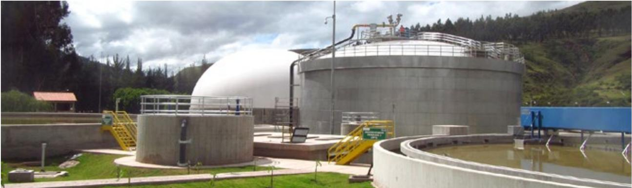
Digestor anaerobio para el tratamiento de lodos municipales
