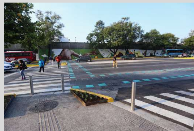
Imagen. Cruce a nivel ubicado en Av. Circunvalación Agustín Yañez y Av. Chapultepec Sur en el municipio de Guadalajara.
