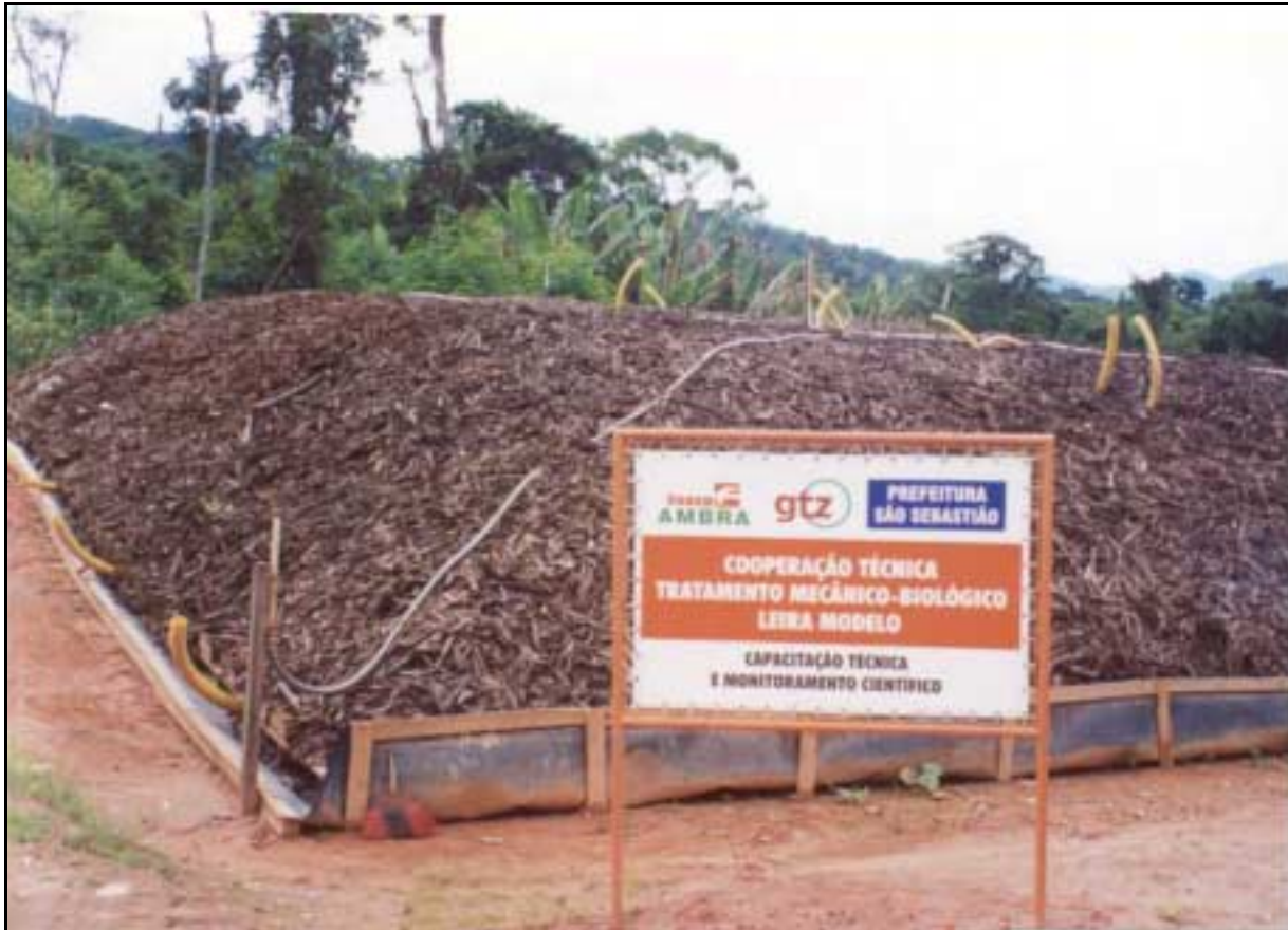
Figura 5: Pretratamiento mecánico-biológico de residuos sólidos en pilas (celda demostrativa) (Foto: Günther Wehenpohl)
